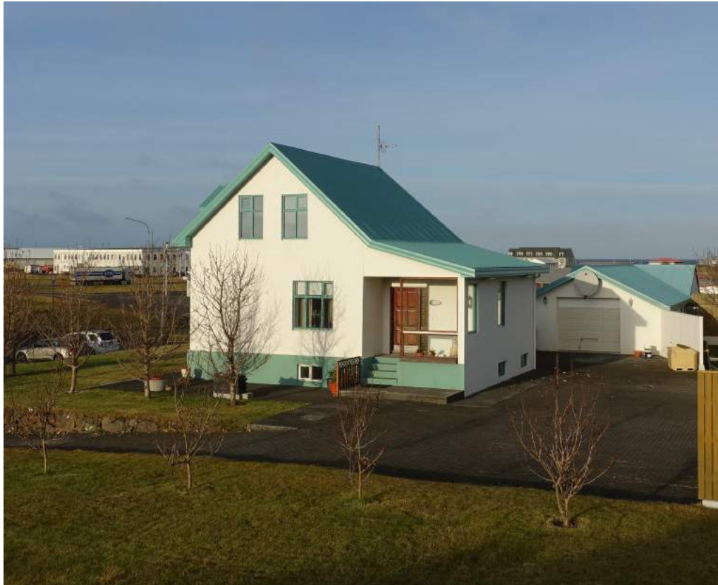
Víkurbraut 15, "Krókskot", byggt 1920. Gott dæmi um steinsteypt hús frá fyrri hluta 20.aldar. Íbúðarhús og útihús, sambyggð hús geyma sögu búskaparháttanna í sjávarþorpi.
