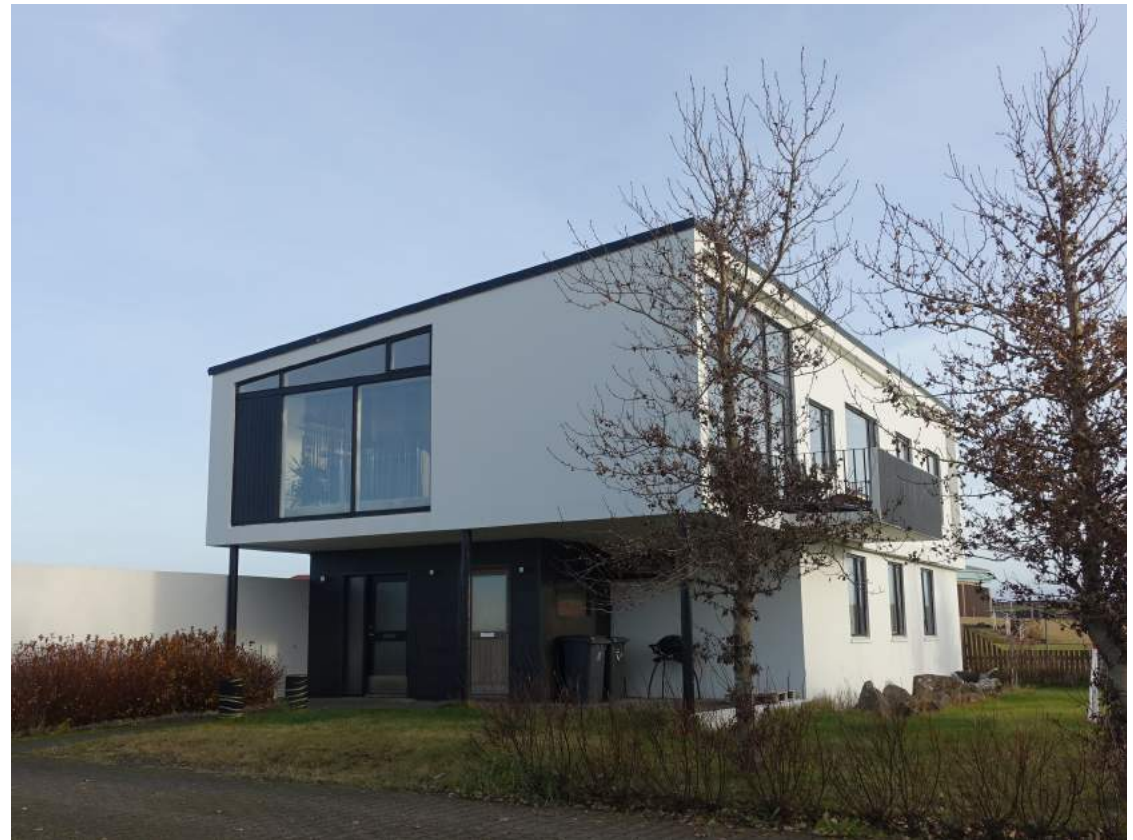
Austurgata 11, byggt 1960. Húsið er gott dæmi um mótternisma í íslenskri byggingarlist. Það stendur á hornlóð og er mikilvægt fyrir götummyndina.
