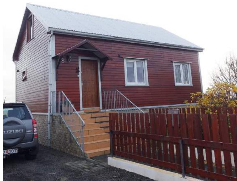
Brekkustígur 8, "Fagurhóll", byggt 1922. Timburhús sem er mikilvægur hluti götumyndar sem smágerð íbúðarhús sunnan Brekkustígs mynda.
